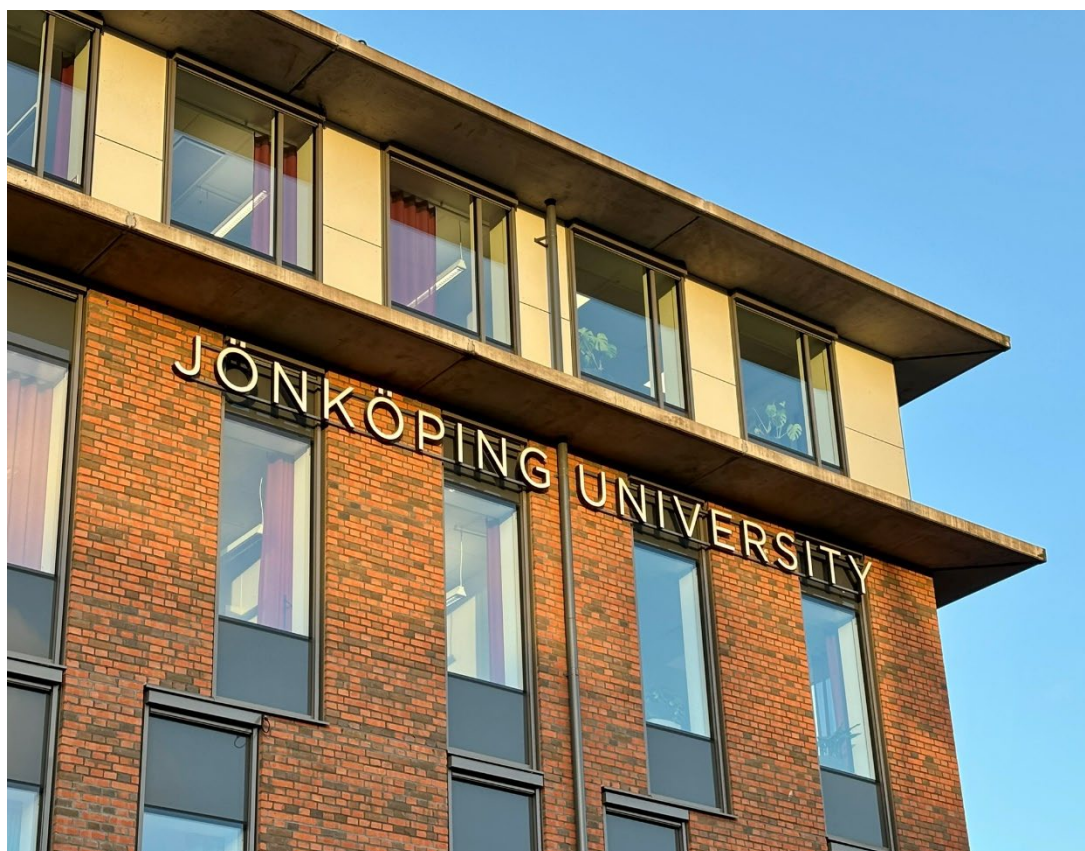
Hus K exteriör
